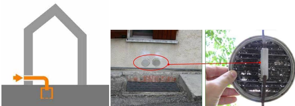
Figure 23 e 24: necessità della manutenzione dei punti di aspirazione dell'aria
